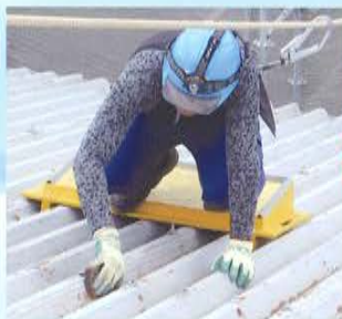
高圧洗浄後下地のケレン
