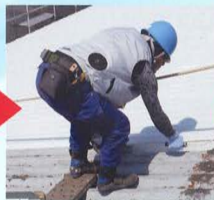
プライマー塗布
