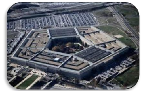
国防総省（ペンダコン）外壁：防護、強化
