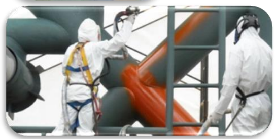
柱脚・構造物の強化・防錆
